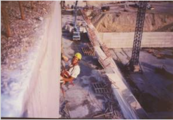
Labores de limpieza en paramento aguas abajo Javier García Gallego
